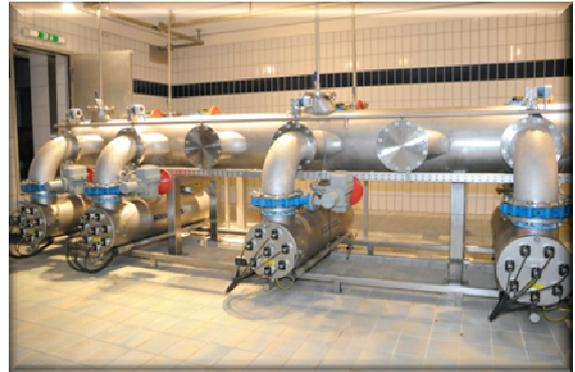
Die neue UV-Desinfektionsanlage gewährleistet die Einhaltung der mikrobiologischen Trinkwasserqualitätsparameter bis zu einer Durchflussmenge von 300 Liter pro Sekunde.
