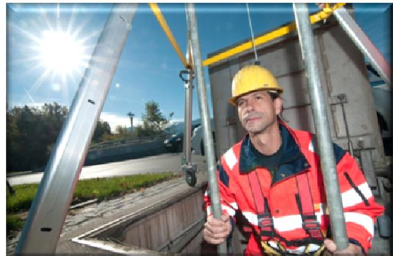
Mit Hilfe modernster Geräte - sogenannter „Geräuschpegellogger“ - werden Leckstellen lokalisiert und die Leitungsgebrechen sofort behoben.
